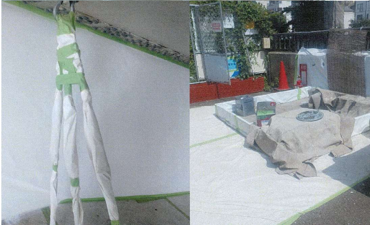
付属設備の養生風景（一般養生テープ使用時）
