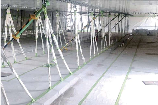
橋梁足場施工状況（一般養生テープ使用時）
