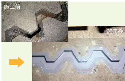
老朽化した伸縮装置 → YKB-J 工法施工後
