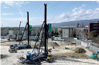
施工中の全景
