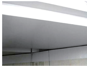
ナイロン繊維シート(特殊加工)/エポシキポリマーセメントによるコンクリート片剥落防止対策システム
